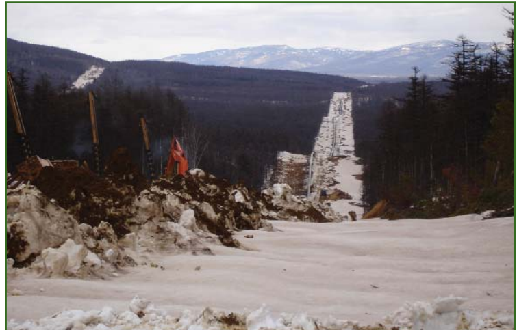
Строительство трубопровода на острове Сахалин
